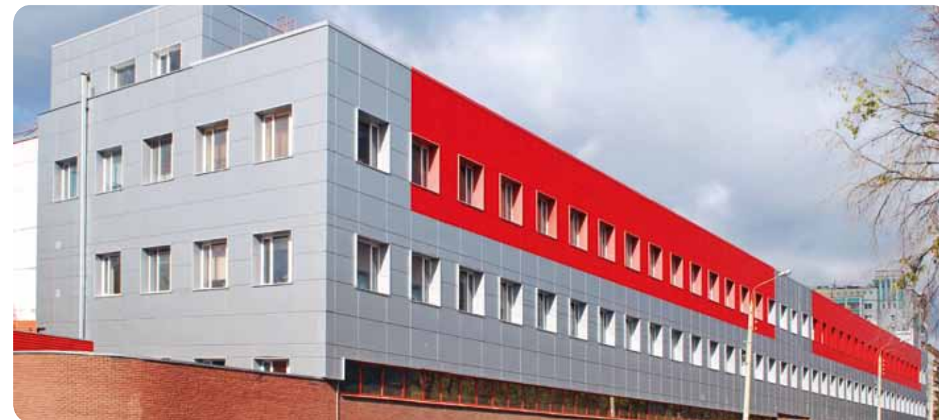
Производственное здание ООО «Кока-Кола ЭйчБиСи Евразия»
